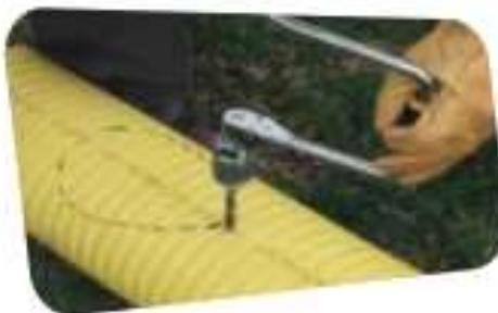
3. Con un serrucho de punta abra el hueco siguiendo el borde exterior de la marca.
