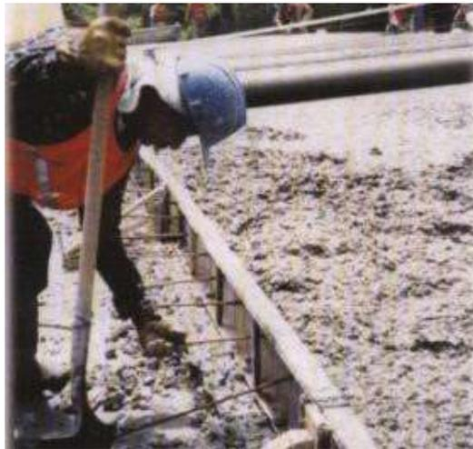
**Inserción manual en pavimento construido con formaleta fija**
