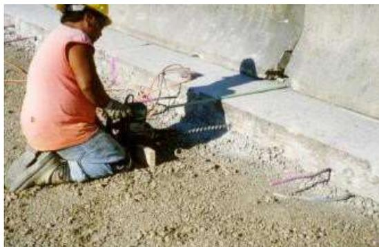
**Perforaciones para inserción de varillas en concreto endurecido**
