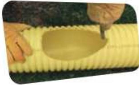
5. Coloque el caucho en la posición marcada teniendo la precaución de verificar que quede al borde del hueco y que coincidan cresta y valle.
