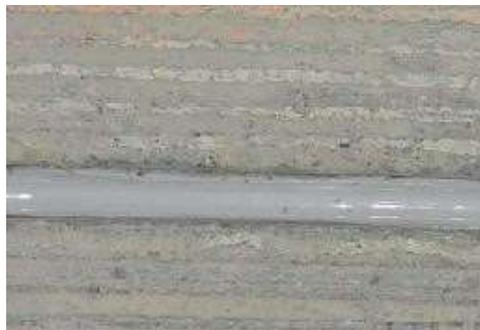
**DETALLE DE UNA JUNTA SELLADA EN FRÍO CON SILICONA**
