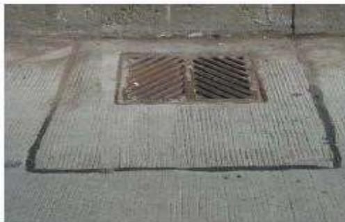
**REFUERZO DE LOSAS CON ESTRUCTURAS FIJAS EN SU INTERIOR**
