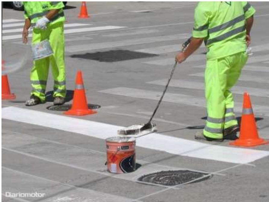
Después de realizar el pintado, \*se vierten sobre las franjas una especie de polvos (vidrio molido) que tienen tres características principales: ayudan a fijar la pintura al cohesionarla, añaden debido a sus minerales un efecto reflectante a la luz y disminuyen sensiblemente la facilidad de deslizamiento.
