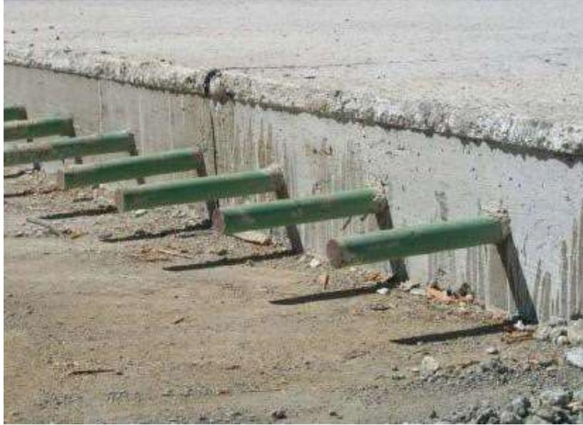
□ La junta longitudinal de construcción se puede elaborar empleando una formaleta fija machihembrada.
