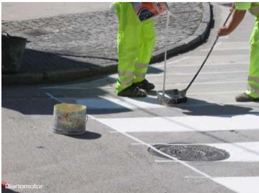
La pintura que se utiliza en los pasos de peatones no es una pintura normal. Tiene unas cualidades más específicas y potenciadas de durabilidad, resistencia y de secado rápido. También es muy importante que esta pintura no se convierta en una pista de hielo cuando llueve, puesto que con anteriores tipos de pintura a más de un peatón y de un motorista se ha puesto en aprietos.
