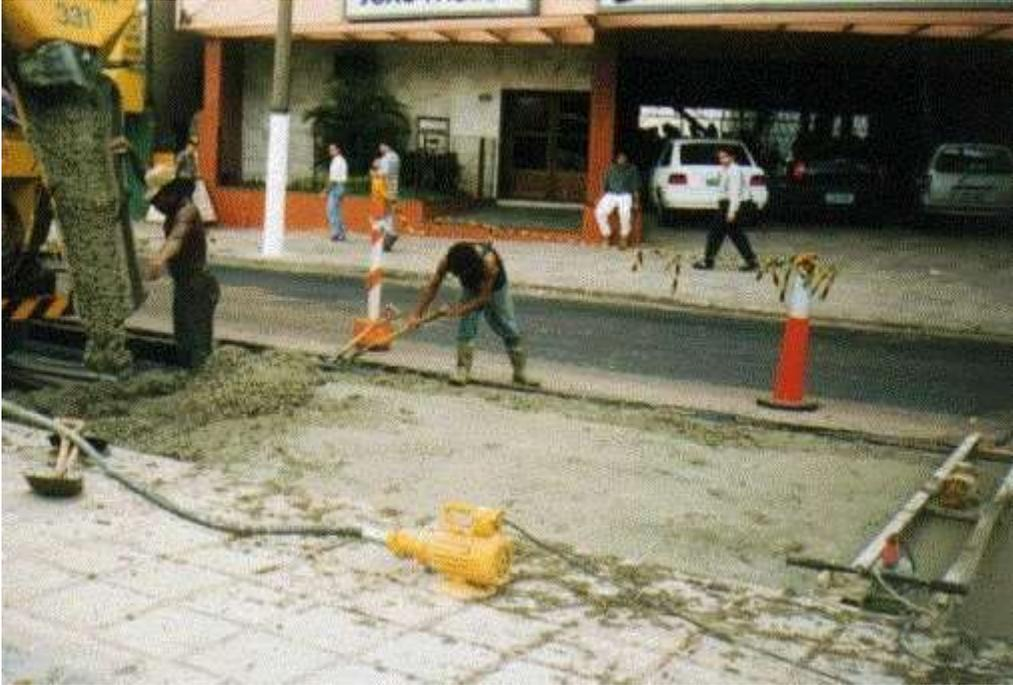
**DESCARGA Y DISTRIBUCIÓN MECÁNICA DEL CONCRETO**
