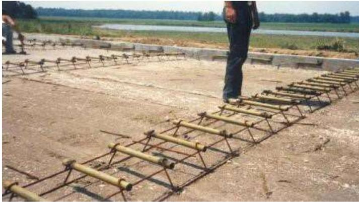
□ Las varillas se deben colocar en correspondencia con la junta transversal del carril contiguo.
